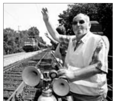
Gleisbau an der Bahnstrecke: Frank Toch überwacht die Arbeiten. Steiner
