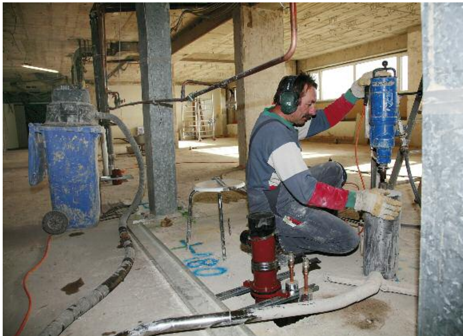
Laute Handwerker: Bald ist der schlimmste Baulärm überstanden.
