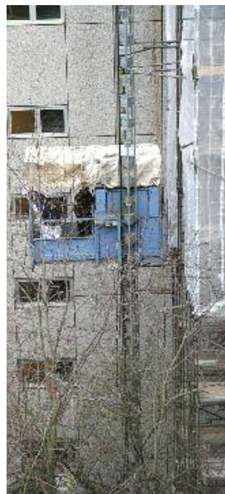
Entsorgt den Bauschutt: Dieser Außenaufzug.
