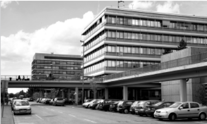
Größte Gebäudesanierung seit MHH-Bestehen: Das Gebäude I3 wird ab August 2007 entkernt.
