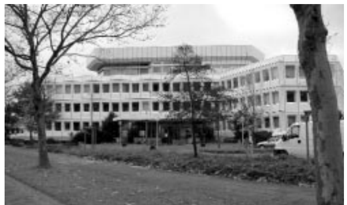
Modern saniert: Das ehemalige Hoechst-Gebäude
